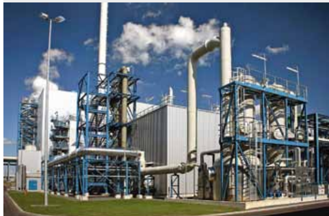
Vattenfalls CCS-anlæg i Janschwalde i Tyskland har fået tilskud 150 mio. euro i tilskud fra EU. Vattenfall er ejet af den svenske stat.
